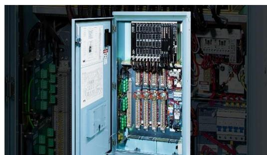
Slika 7. Kontroler u adaptivnom semaforu
