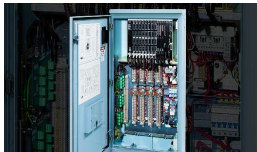
Slika 7. Kontroler u adaptivnom semaforu
